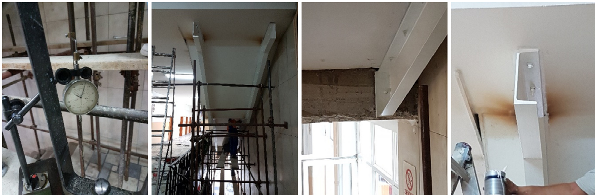
Сл. 9. Изведба на конструкција за санација и зајакнување
