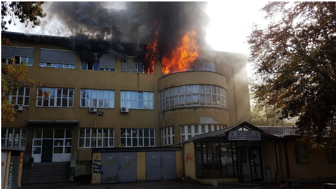
Сл. 1. Пожар на конструкција
