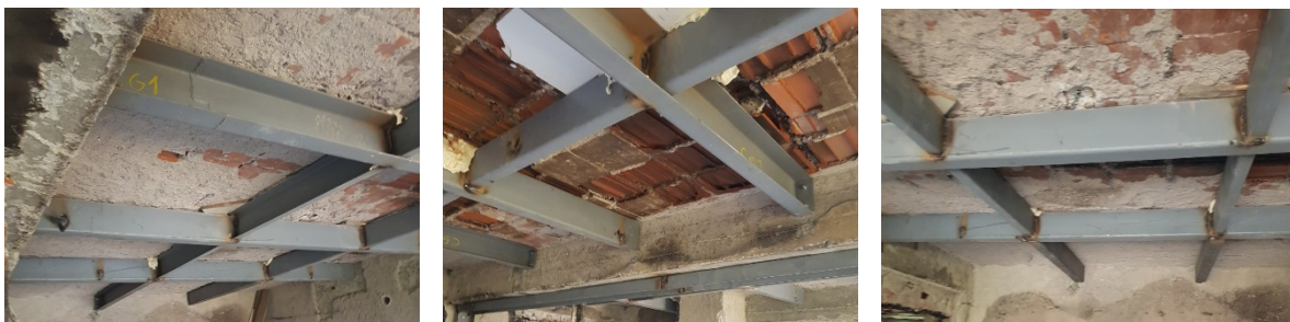
Сл. 7. Конструкција за санација на меѓукатна „монта-ферт“ плоча
