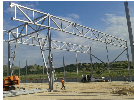
Слика 11. Изведен монтажен сегмент
