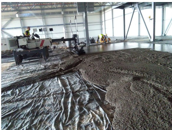
Слика 7. (лево и десно) Изведба на подна плоча
