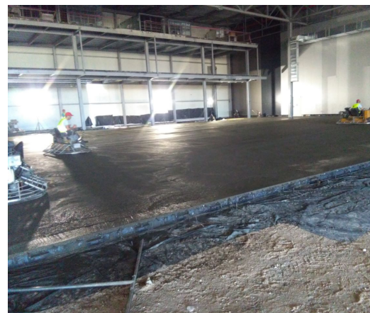
Слика 7. (лево и десно) Изведба на подна плоча
