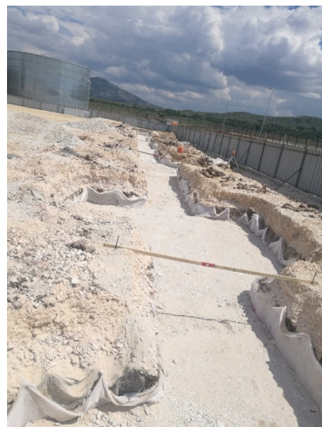
Слика 2. Изведба на темелниот ископ
