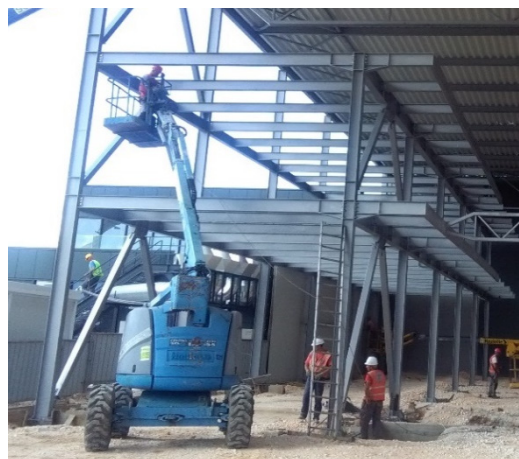
Слика 15. Изведба на меѓукатна к-ција
