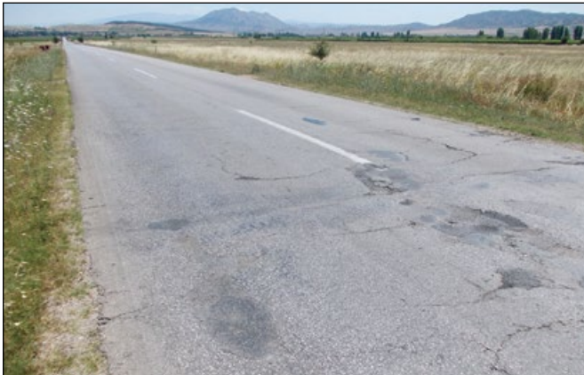
Izgled postojećeg stanja puta
