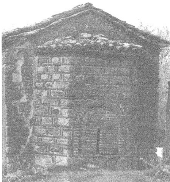
Сл.9 источна фасада
