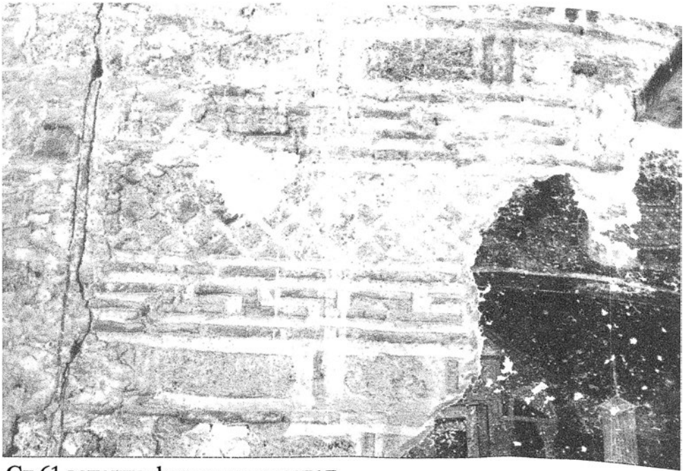
Сл.61 западна фасада на спратот на нартексот - детал
