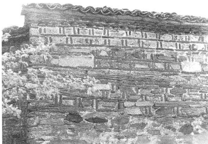
Сл. 11 северна фасада
