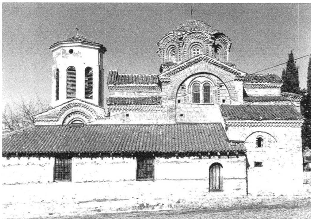
Сл. 34 јужна фасада
