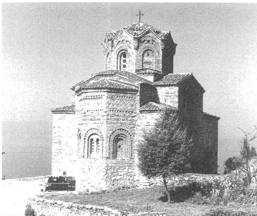
Сл.27 источна фасада
