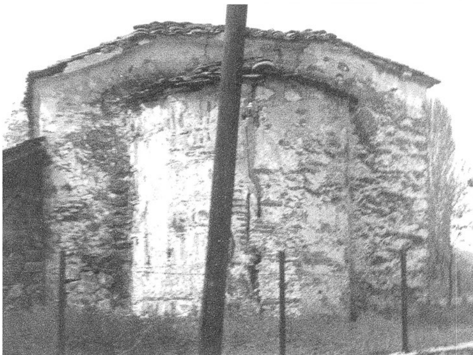
Сл.38 источна фасада
