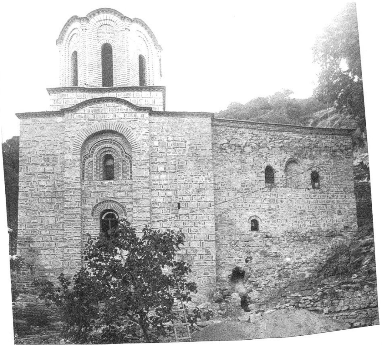
Сл.44 јужна фасада
