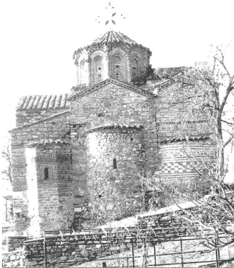
Сл.65 источна фасада
