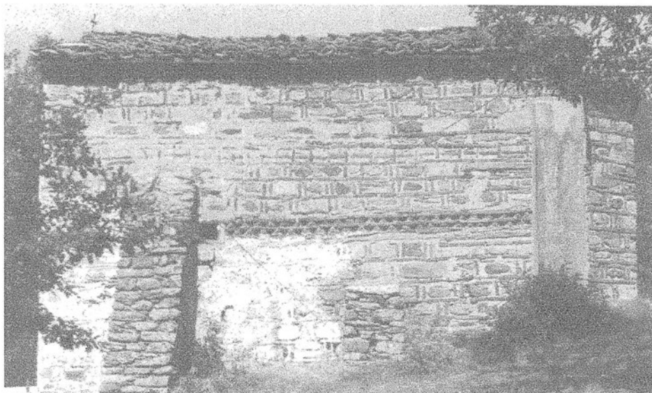
Сл. 8 јужна фасада
