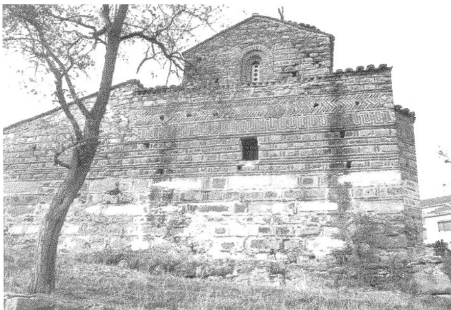
Сл.68 јужна фасада
