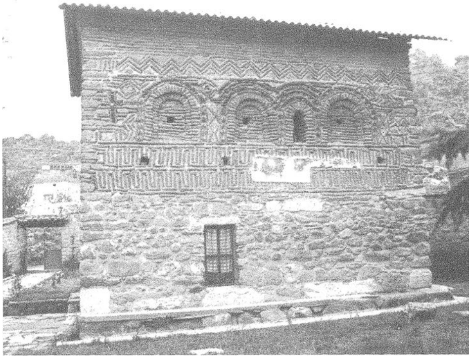
Сл. 12 јужна фасада
