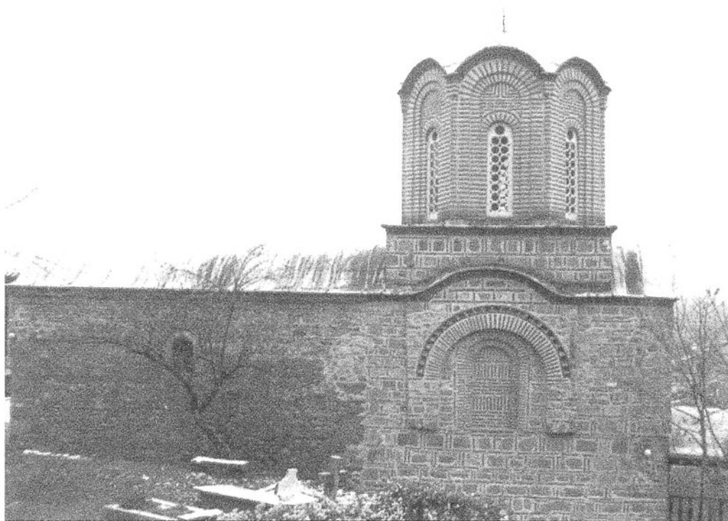
Сл.41 северна фасада
