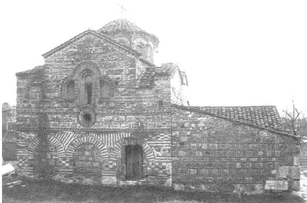
Сл.67 северна фасада
