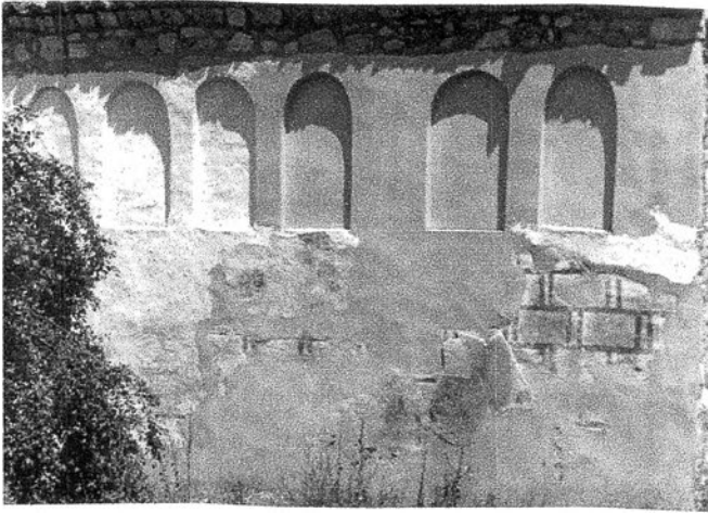
Сл.3 јужна фасада, детал
