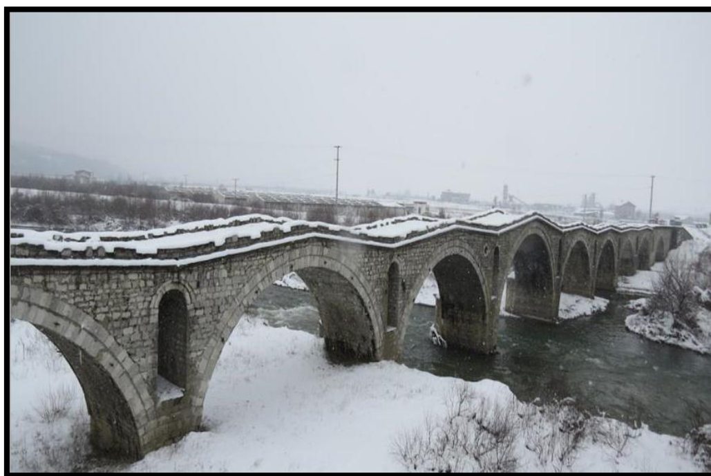
Сл.288. Мостот на Терзив во Биштажин
