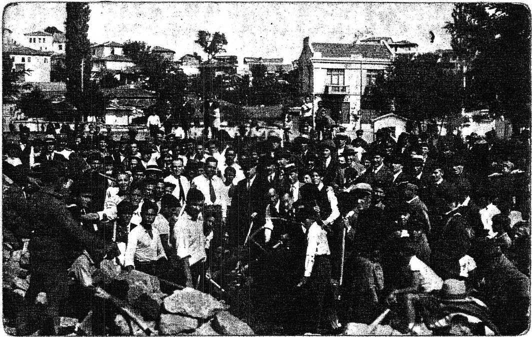
Поставување на кемеј темелникот на новиот Соколски дом 1935 година
