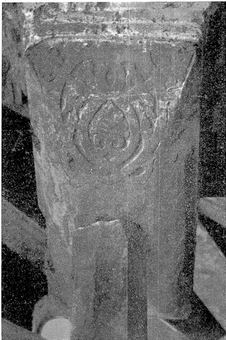
Сл. 17 — Капител од северниот трибилон на катот од ексонартексот во св. Софија во Охрид.
