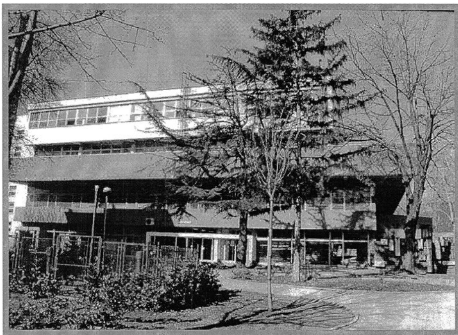
Објектот на Домот на културата „Крсте Пейков Мисирков“ во кој е сместена Народната библиотека „Гоце Делчев“ – Свети Николе
