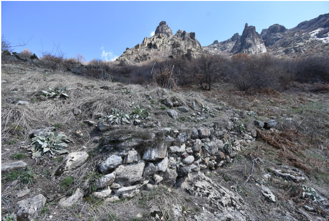
Сл. 239 - Марков Сид, Прилепец, одбранбениот ѕид на југоисточната ѕиданбена тераса
