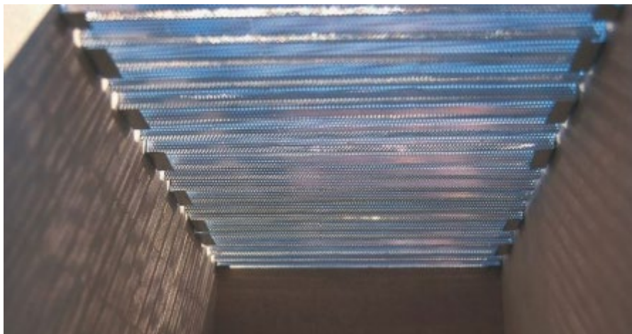
Слика 3.12: Прототип на носечка покривна конструкција
