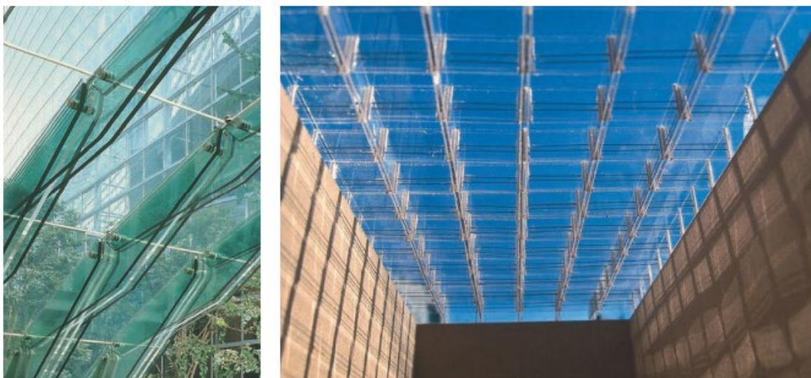
Слика 3.2: Наставување на носачи [Glass Structures]
