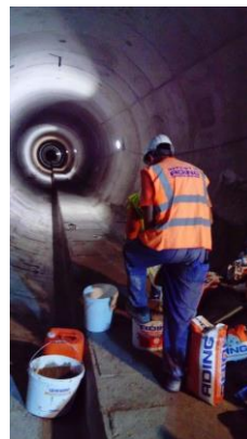
Zaštita konstrukcije HT tunela
