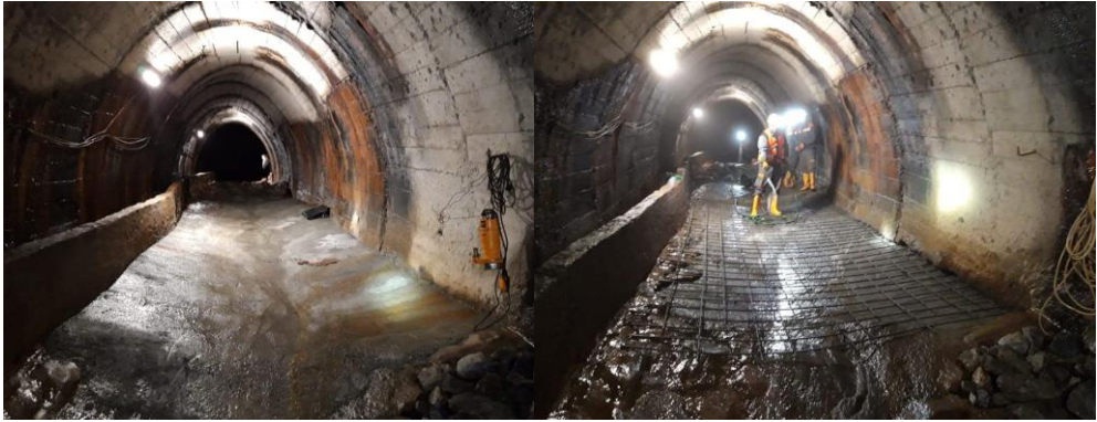
Reprofiliranje reparaturnim malterom visoke čvrstoće i otpornosti na habanje EKSMAL 16 SASA
