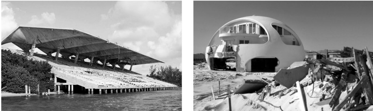
Сл. 1 Поморскиот стадион во Мајами (Мајами, САД, 1967) - армирано-бетонска лушпа во форма на хиперболичен параболоид; Станбената армирано-бетонска купола (Пенсакола Бич, САД, 2002)
