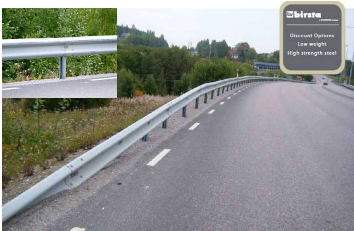
Слика 34. Одбојник за заштита на патишта со W профил
