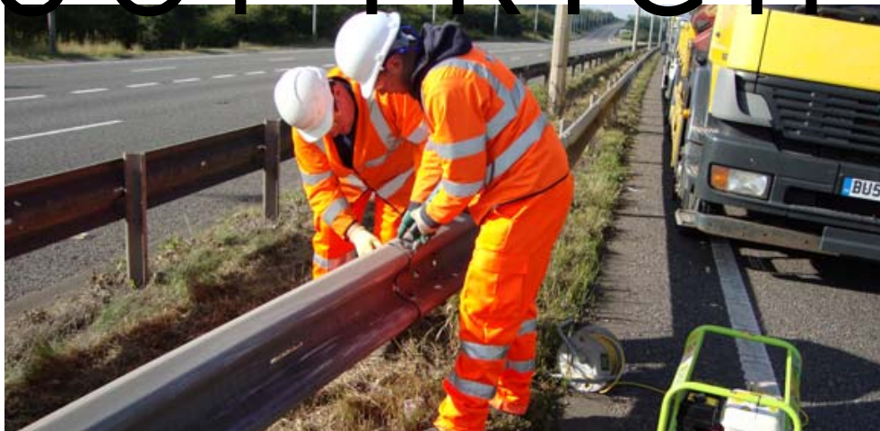
Слика 31. Поставување на одбојници за заштита на патиштата
