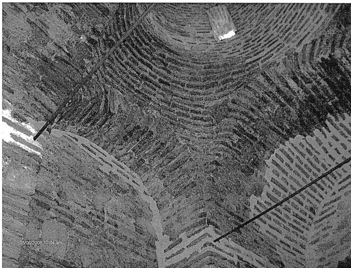
Сл. 1 Латинска црква, поглед од северозапад (снимил М. Марковиќ) Сл. 2 Латинска црква, пандантифи во зоната на поврзување
