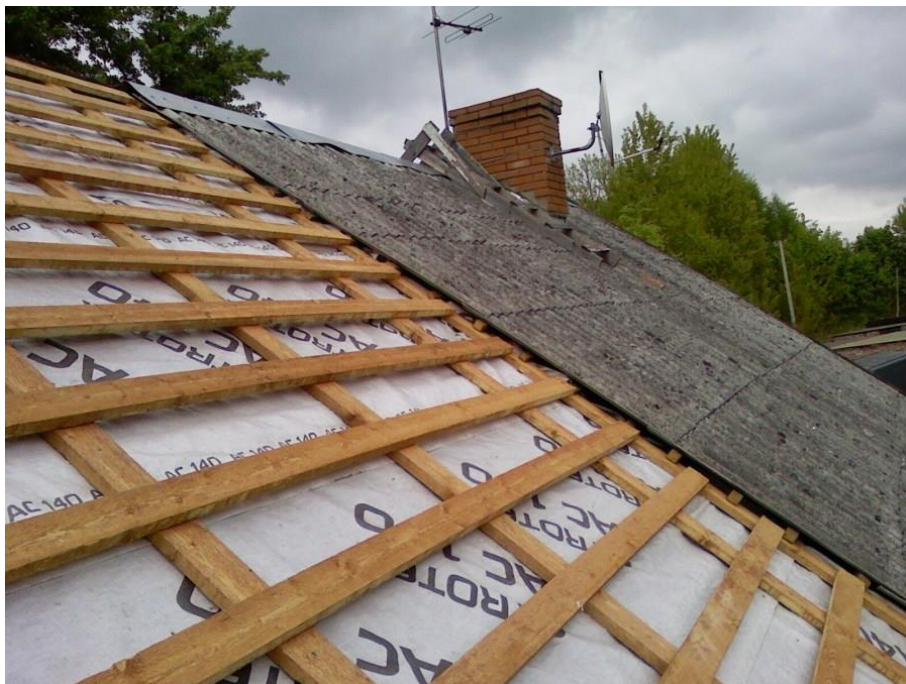
Слика 51. Дрвени летви на покривна конструкција (извор: www.decorexpro.com )
