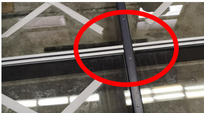
Слика 4.4.11: Деформации во врска помеѓу профилите и врска помеѓу стаклата
