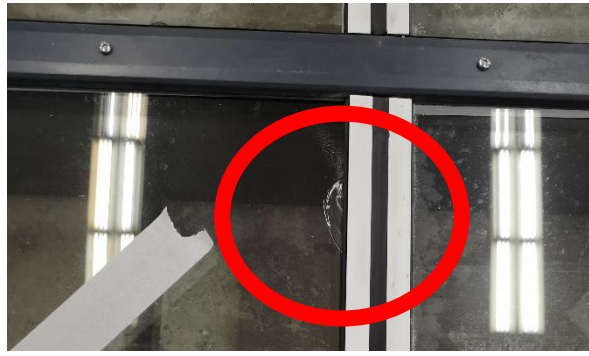
Слика 4.4.13: Појава на пукнатини при испитување на првиот модел
