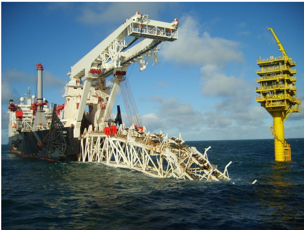
сл. бр. 6 Изградба на гасоводот „Северен тек“ – механизација за поставување цевки
