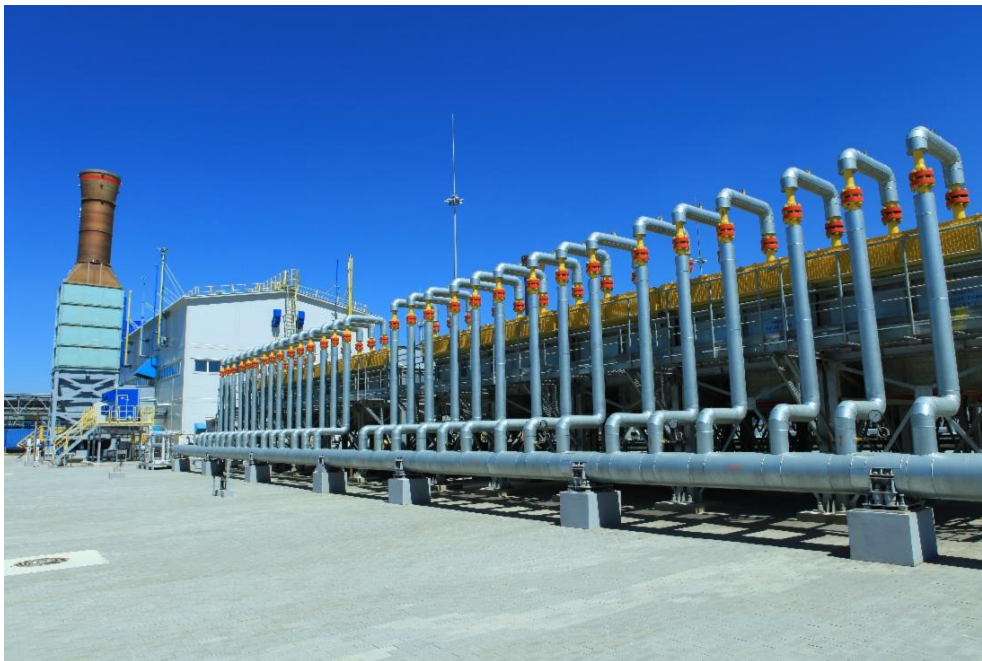
сл. бр. 4 Компресорна станица „Рускаја“ на гасоводот „Турски тек“ преземено од: https://www.gazprom.com/preview/f/posts/08/395125/w1100_10-11-2016_turkey-8.jpg
