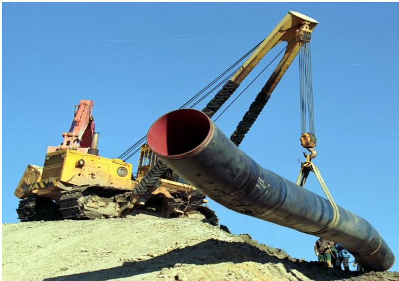
сл. бр. 3 Челични цевки отпорни на корозија кои се користат при изградба на гасоводот, преземено од: https://www.gazprom.com/f/posts/65/395913/3.jpg
