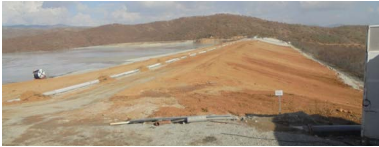
Fig. 2 Crest and waste lagoon of tailings dam Buchim, March, 2016 Crête et lagune de déchets du barrage de résidus Buchim, mars 2016
