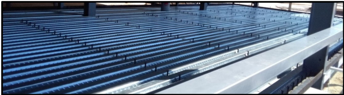
Сл. 1. Спрегната меѓукатна конструкција во фаза на изведба
