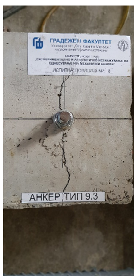
Сл. 6. Лом проследен со цепање на бетонот при максимално достигнат товар
