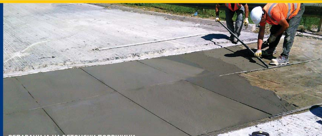
РЕПАРАЦИЈА НА БЕТОНСКИ ПОВРШНИ НА АВТОПАТ МИЛАДИНОВЦИ - КАТЛАНОВО
