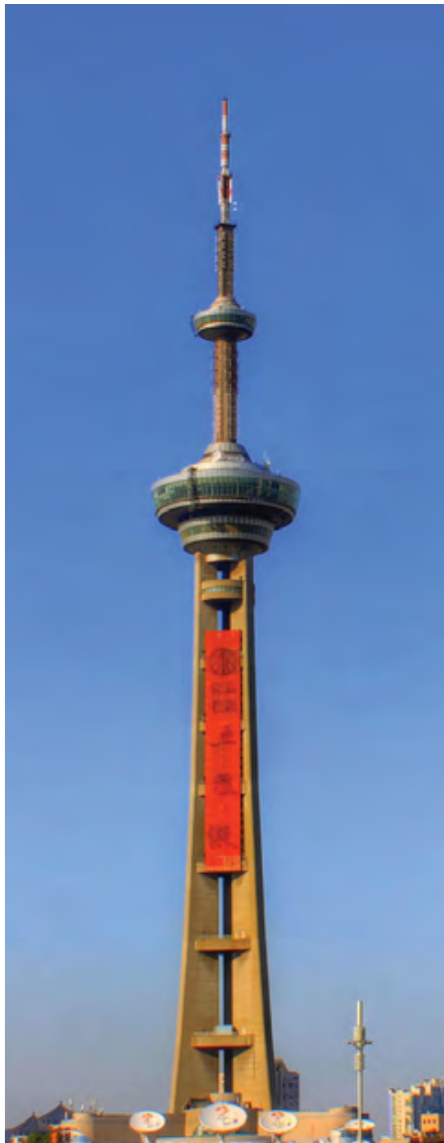
Nanjing TV Tower Локација: Нанкин, Кина. Висина: 310 м. Изградена: 1990 година Тип на управување: AMD во облик на прстен со три побудувачи поставени под агол од 120°
