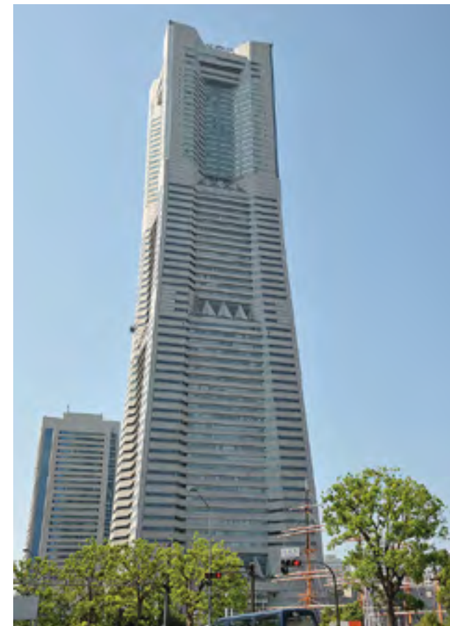
Landmark Tower Yokohama, Yokohama, Kanagawa Prefecture, Japan Висина : 296 м, 70 ката. Вкупна површина : 231,060 m 2 Тежина : 260,600 t. Конструкција: челична конструкција и временна армиранобетонска конструкција со челик Сопствена периода: Приближно 5,4 sec. Проектирање и менаџмент: Mitsubishi Estate Company, Limited Изведувач: Taisei Corporation and Joint Ventures Тип на управување: Два хибридни апсорбери со подесена маса (HMD) Маса на апсорберот: 340 t Локација на апсорберот: на врвот на зградата
