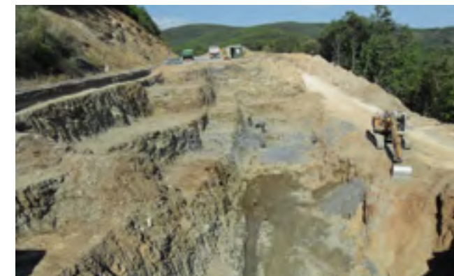
Слика 6. Свлечиште на регионалниот пат Битола - Ресен, месност Гавато. а) во фаза на појава, б) во фаза на санација (вкупна инвестиција за санација, проектирање и изведба околу 600 000 евра)
