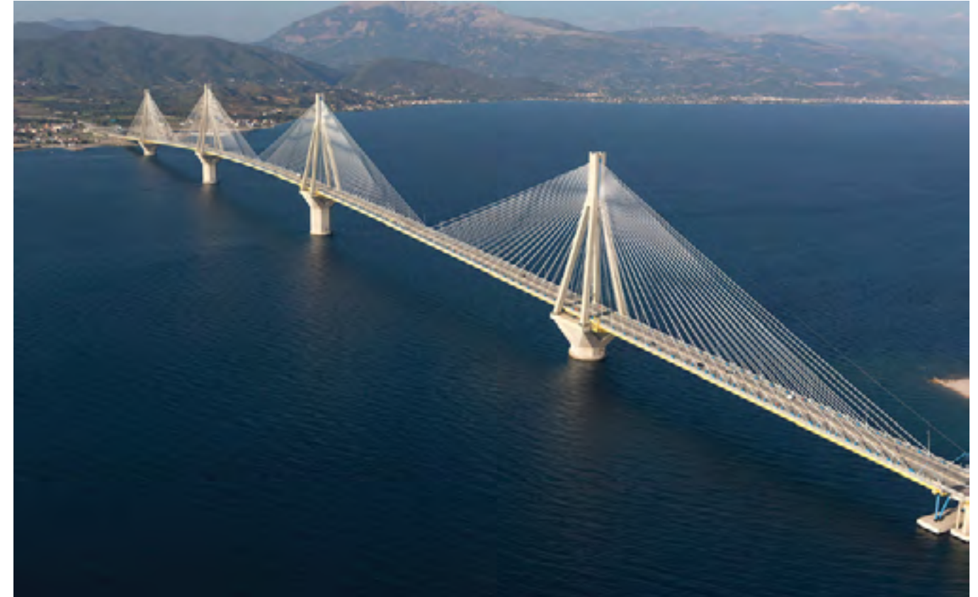
Rion Antririon Bridge. Локација: Пелопонез, Грција. Изграден: 2004. Вкупна должина: 2860 m. Главни распони: 3 распони по 560 m. Секој Странични распони: 2 по 285 m. Висина над нивото на морето: 160 m. Тип на управување: Вискозни дамperi за контрола на движењето на платформите на мостот за време на земјотрес
