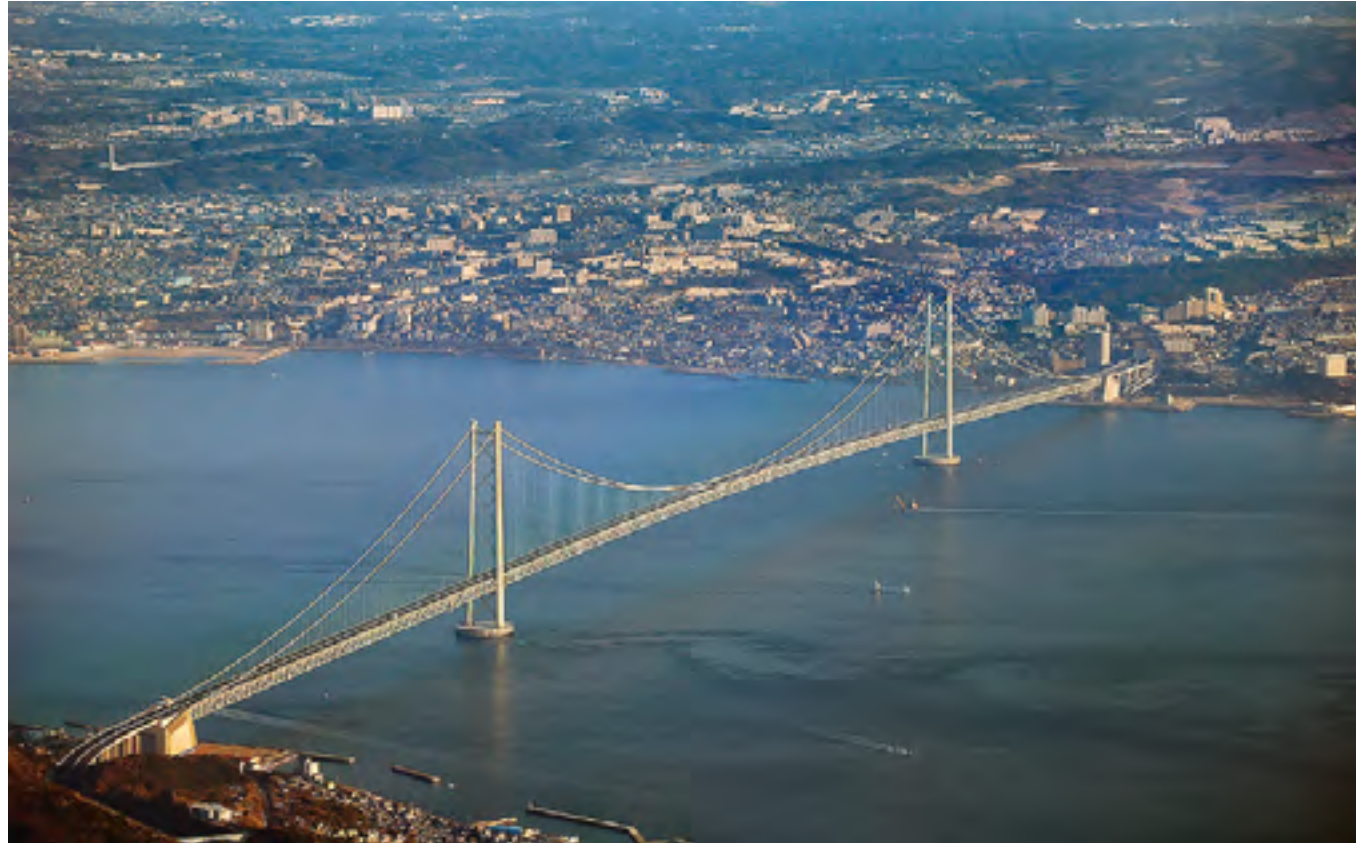
Akashi Kaikyo Bridge. Локација: Kobe и Awaji-shima, Japan. Изграден: 1998. Цена: 4,3 милијарди долари. Вкупна должина: 3911 m. Главен распон: 1991 m. Тип: Висечки (Suspension). Материјал: Челик. Проектант: Satoshi Kashima. Одржување: Honshu-Shikoku Bridge Authority. Тип на управување: по 20 TMD инсталирани на двата главни столба
