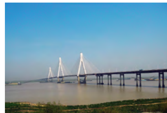
Dongting Lake Bridge. Тип: cable-stayed, Должина 880 м Четири распони: 130+310+310+130 (m) Тип на управување: 312 магнетореолошки (MR) дамperi инсталирани на 156 кабли. Прва практична примена на технологијата на интелигентни MR-материјали
