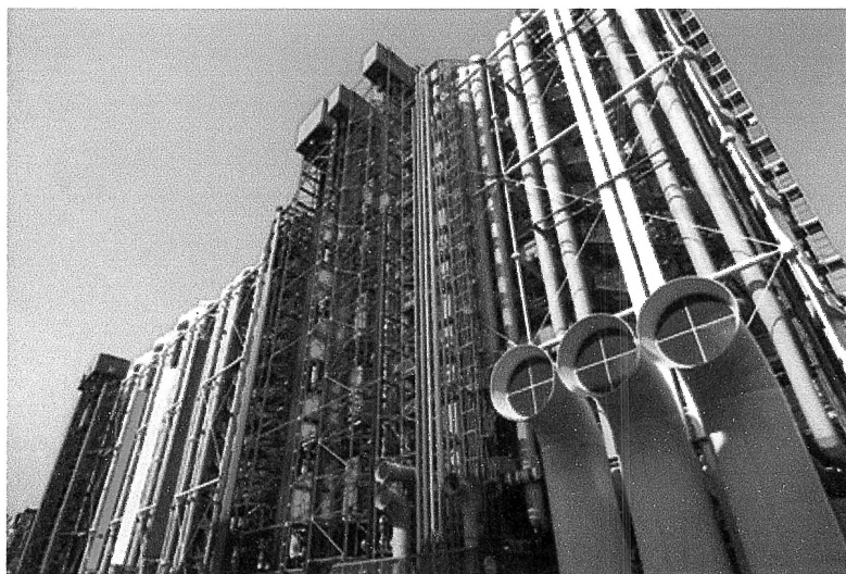
Слика 38. Центарот Помпиду – надворешна конструкција
