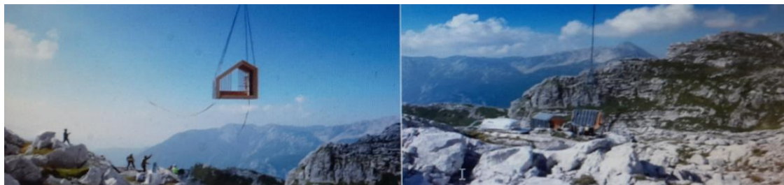
Слика 14 и 15 „Транспортирање на посебните модули“
