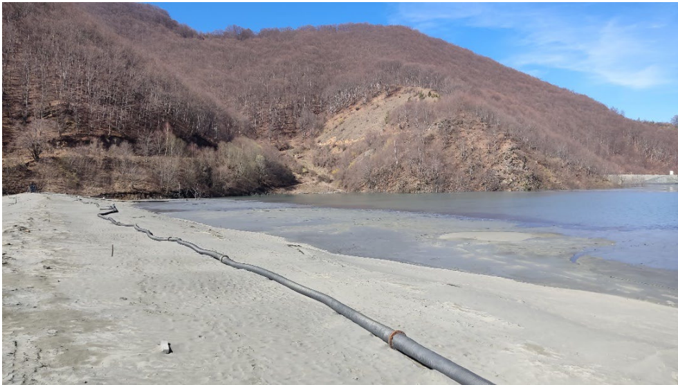
Слика 1.2. Хидројаловиште Тораница#1, таложно езеро низводно од горната брана, круна и низводна (водна) косина на узводната комбинирана свртувачка брана, со височина околу 50 м за состојба во 2023 година
