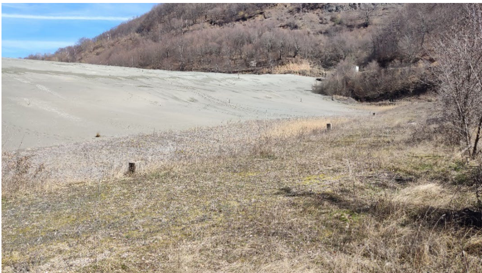
Слика 1.3. Хидројаловиште Тораница#1, узводна (воздушна) косина на узводната комбинирана свртувачка брана, со берма на 977.5 мнв во ниво на круната на првобитната каменоземјена брана) за состојба во 2023 година
