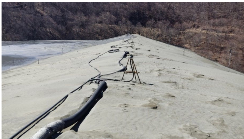
Слика 1.1. Хидројаловиште Тораница#1, таложно езеро узводно од долната брана, круна и низводна (воздушна) косина на низводната јаловишна брана од циклонираниот песок, со височина околу 70 м, за состојба во 2023 година
