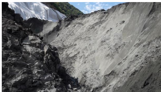
Слика 3.3. Однесен јаловиштен песок од низводното тело на браната во непосредна близина на десниот бок
