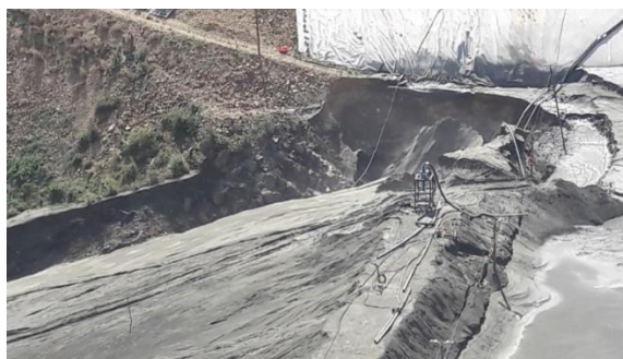
Слика 3.1. Оштетување во десниот дел на јаловишната брана, состојба на 14.9.2020 г.
