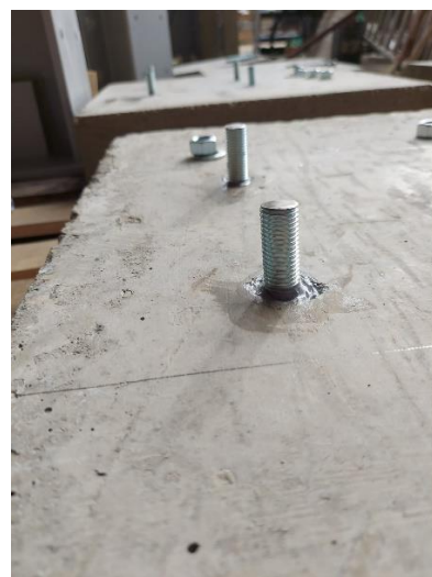
Сл. 2. Вгредени анкери со помош на епоксиден малтер
