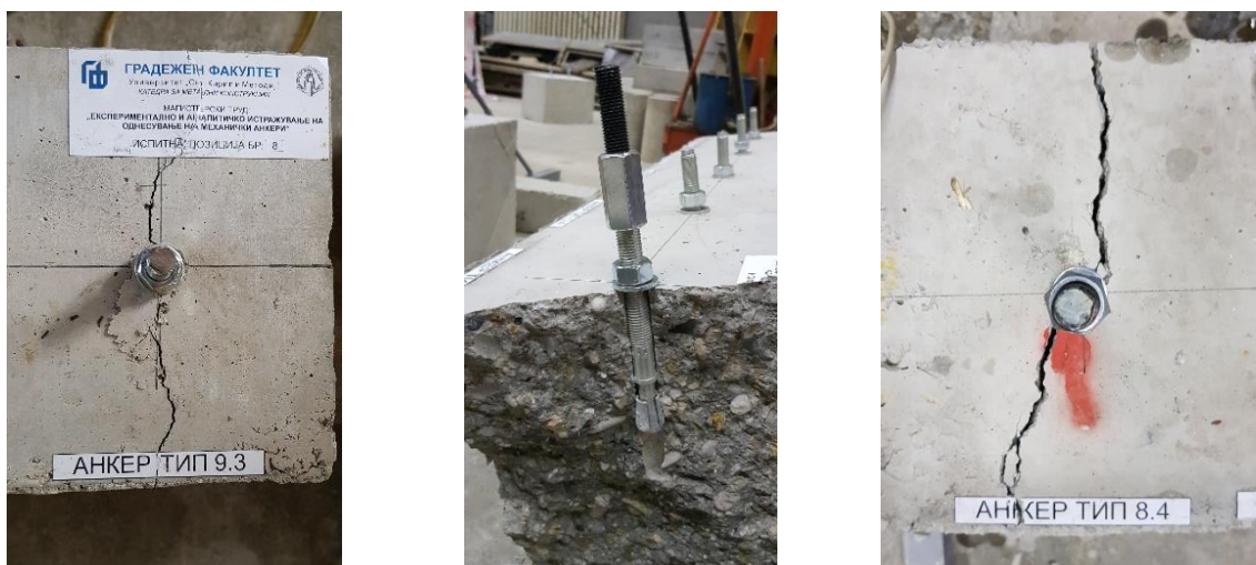
Сл. 7. Карактеристичен лом со цечење на бетонот
