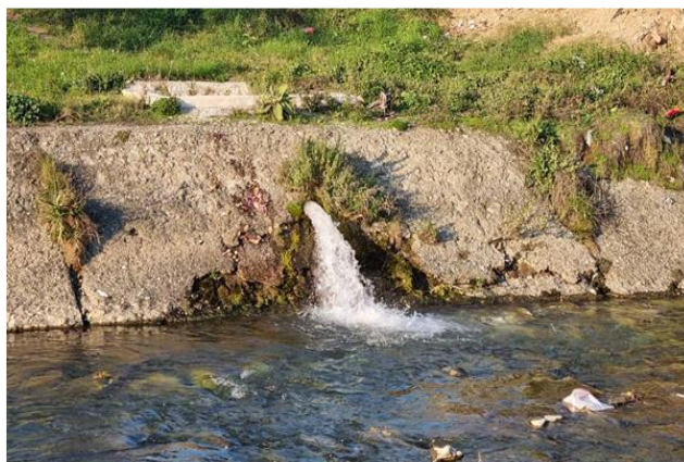
Slika 3. Ispusti vode u reku Vardar u cilju smanjenja pritiska u vodovodnoj mreži
