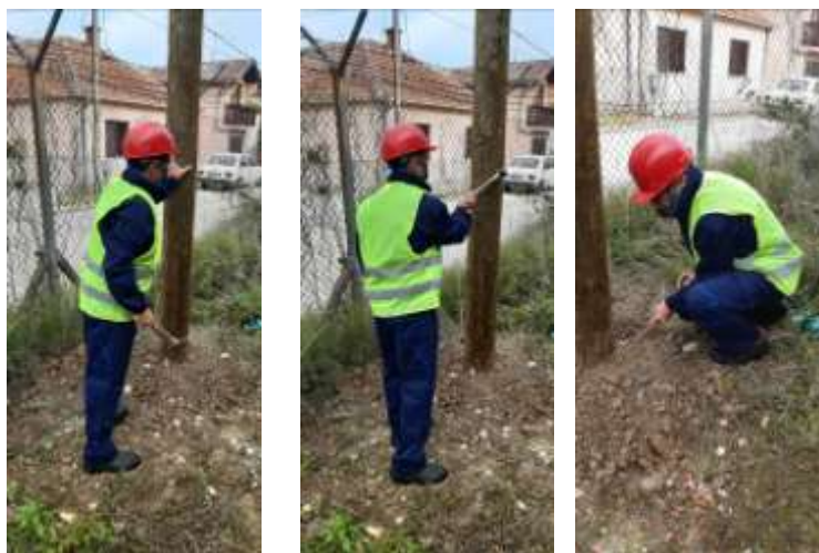
Слика 2. Провера исправности дрвеног ТТ стуба
