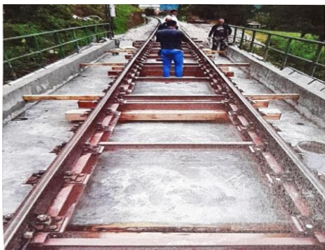
Spuštanje koloseka na betonsku podlogu
