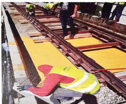
Spuštanje koloseka na betonsku podlogu
