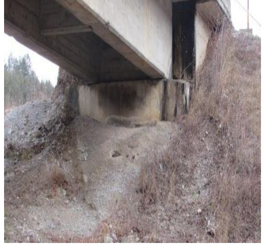
Zasječena nožica nasipa i nasipanje u zoni oporca
