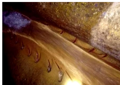
Slika 1 - Oštećenja kanala za sprovođenje vode
