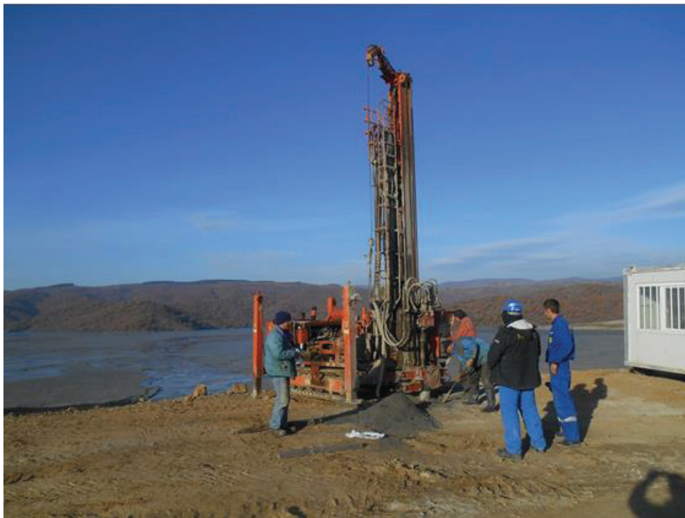
Слика 2. Изведба на геотехничка дупнатина Д-2
