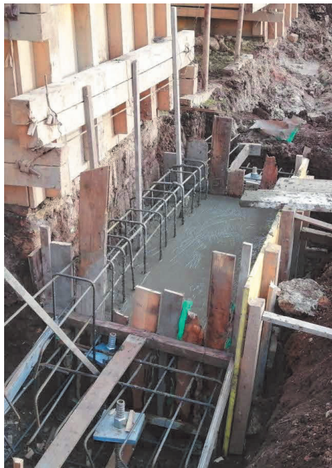
Сл. 15 Избетониран долен дел од ободна надколова L-конструкција
