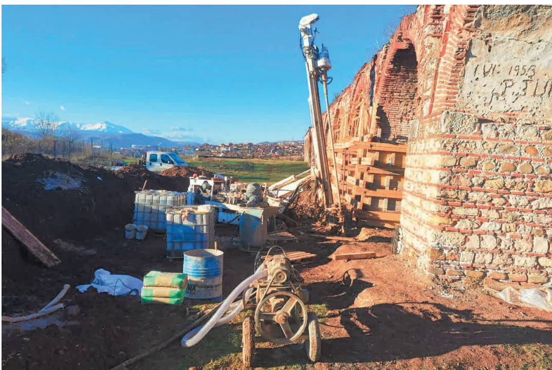
Сл. 11 Изведба на микроколони со машинска гарнитура Casagrande C6
