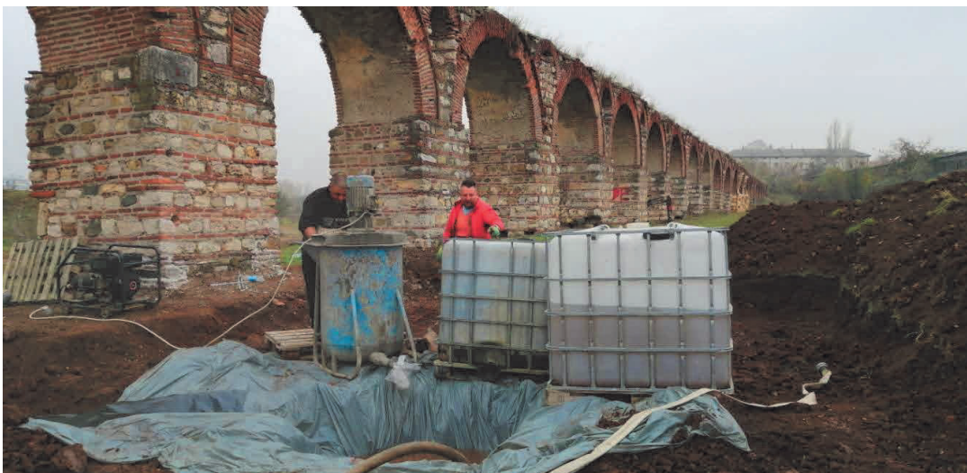
Сл. 9 Подготовка на исплака за дупчење на микроловите
