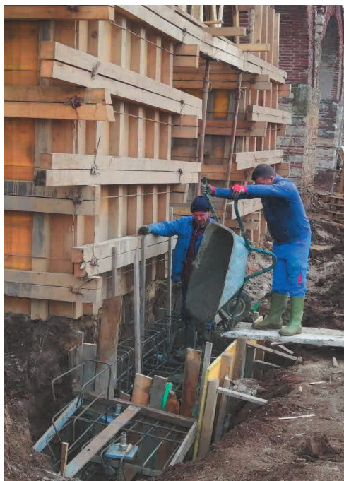
Сл. 14 Бетонирање на дел од ободна надколова L-конструкција
