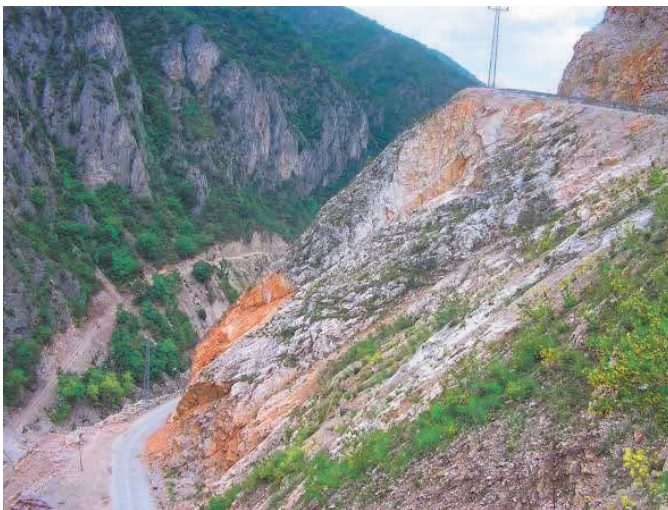
Slika 5. Izgled analizirane kosine sa kinematskim uslovima za planarni lom (levo);
