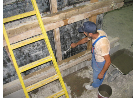
(d) External vibration of concrete by hammer
