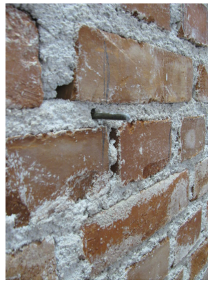
(d) Close-up view of the connection anchor
