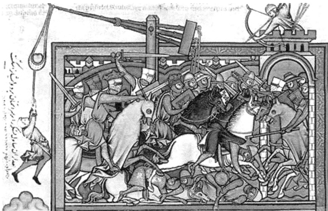
Сл. 10 Претстава на тракциски требушет од т.н. trestle frame варијанта, на левиот крај од минијатурата може да го забележиме операторот кој што ја затегнува праќата пред исфрлање. Минијатура од XIII век во Maciejowski Bible . (Nicolle & Thompson, 2002, стр. 11)
