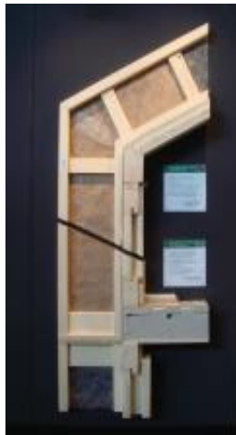
Слика 6 (лево) – Изолација со дрвена рамка (погодна за просторна ефикасност)
