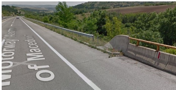
Slika 3. Neodgovarajući spoj elastične ograde sa ogradom na objektu na autoputu A1, deonica Veles-Negotino Izvor: Google Maps/Street view
