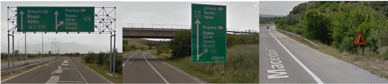
Slika 1. Nezaštićena saobraćajna signalizacija na autoputu A1, deonica Kumanovo-Skopje Izvor: Google Maps/Street view
