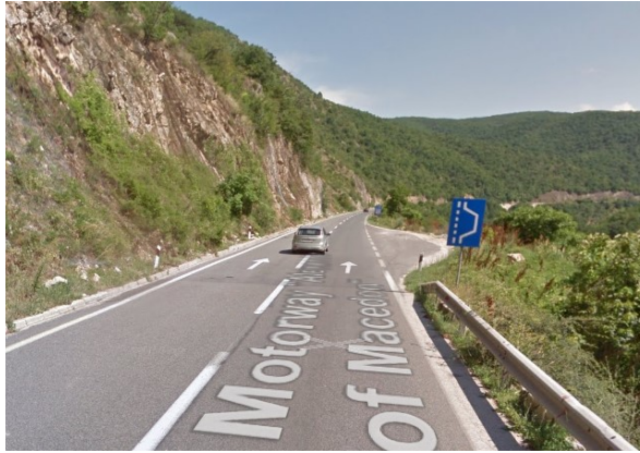
Slika 4. Neodgovarajuća postavljena zaštitna ograda na autoputu A1, deonica Skoplje - Veles Izvor: Google Maps/Street view
