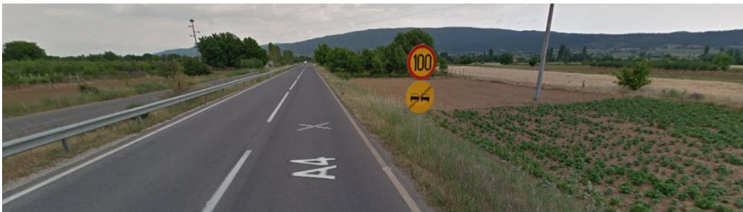
Slika 5. Izostavljena zaštitna i ograda od žice na putevima sa dozvoljenom brzinom većom od 100 km/h na magistralnom putu A4, deonica Prilep - Bitolj Izvor: Google Maps/Street view
