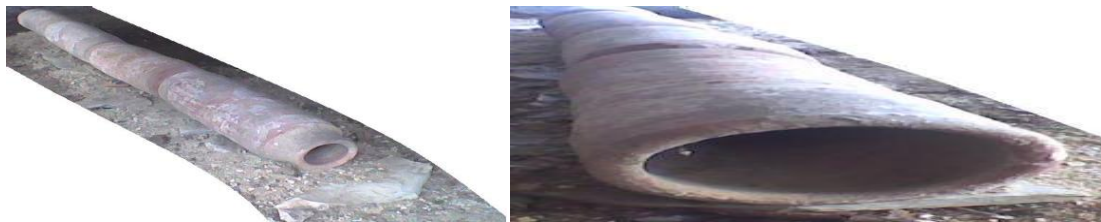
Figura 3. Pamje e gypave të ujësjellësit prej qeramike në kanal në profilin e ngushtë dhe të gjerë në thellësi 45cm (1980).
