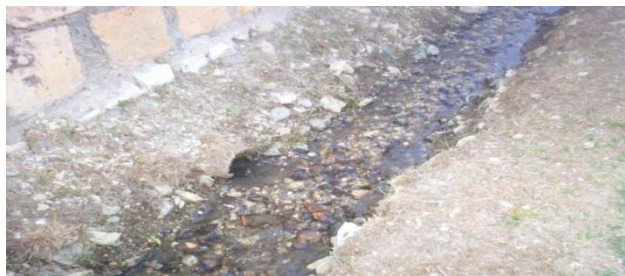
Foto 2. Ujra te zeza ne lagjen Ballshi fshat te drenuara ne nje kanal te hapur ne natyre
