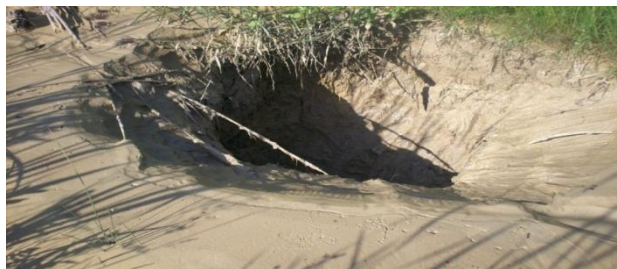
Foto 1. Hinka e depresionit, pasqer të ciles ndodhet tubacioni i ujit të pijshëm.
