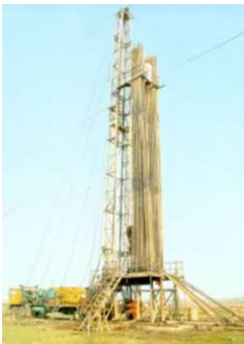
Slika 1. Toranj postrojenja za istraživanje nafte i gasa.
