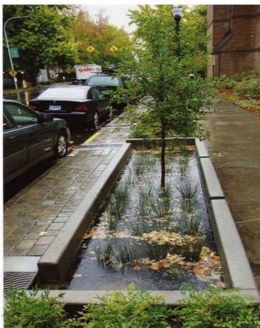
Слика 36 Решение за одвод на дождовница
