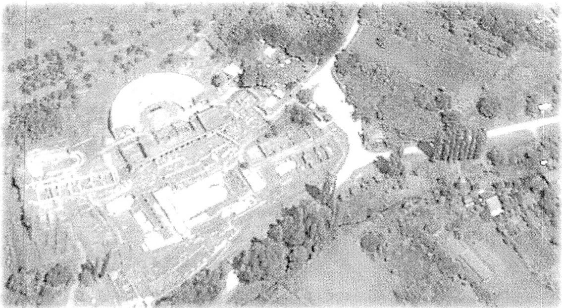
Сл. 6 Хераклеја Линкестис (фото GoogleEarth)
