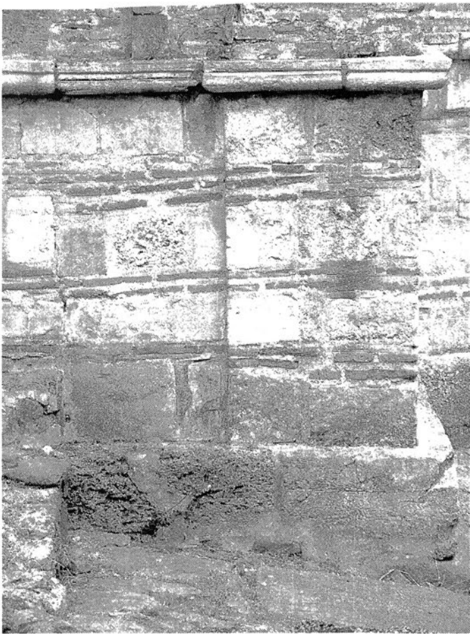
Сл. 56. Фрагмент од преправаната сидарија од првата зона на наосот - источен потесен травеј од јужната фасада
