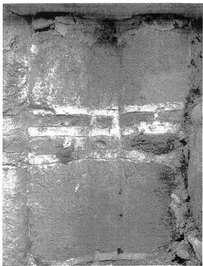
Сл. 88. Фрагмент од оригиналната сидарија на северозападниот профилиран пиластер
