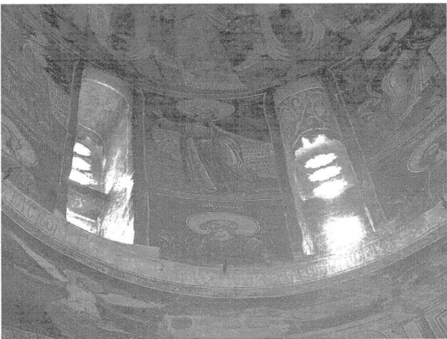
Сл. 206. Фрагмент од главната купола со монофорите и поткуполниот кружен венец
