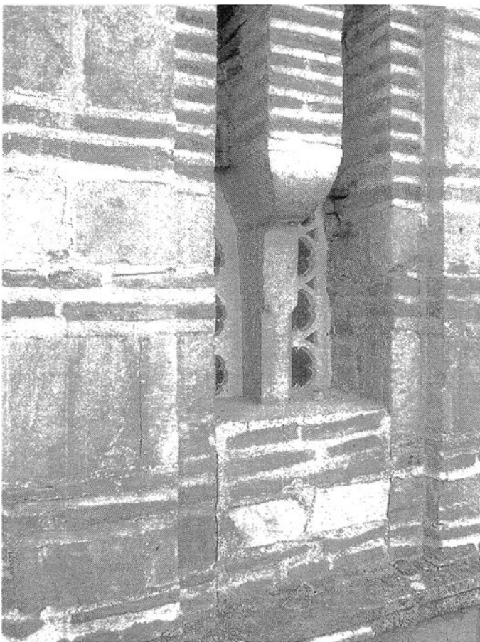
Сл. 103. Бочен изглед на бифоралното мено од апсидата со засидувањето во долниот дел
