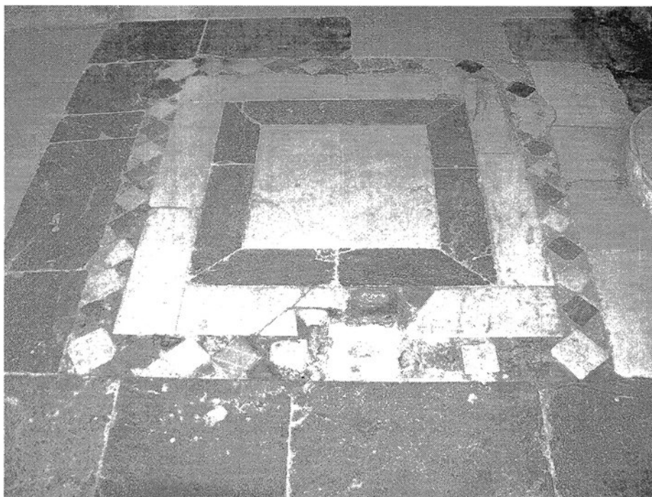
Сл. 237. Обработка на подот во централниот поткуполен травеј од наосот со видливи оштетувања во јужниот дел
