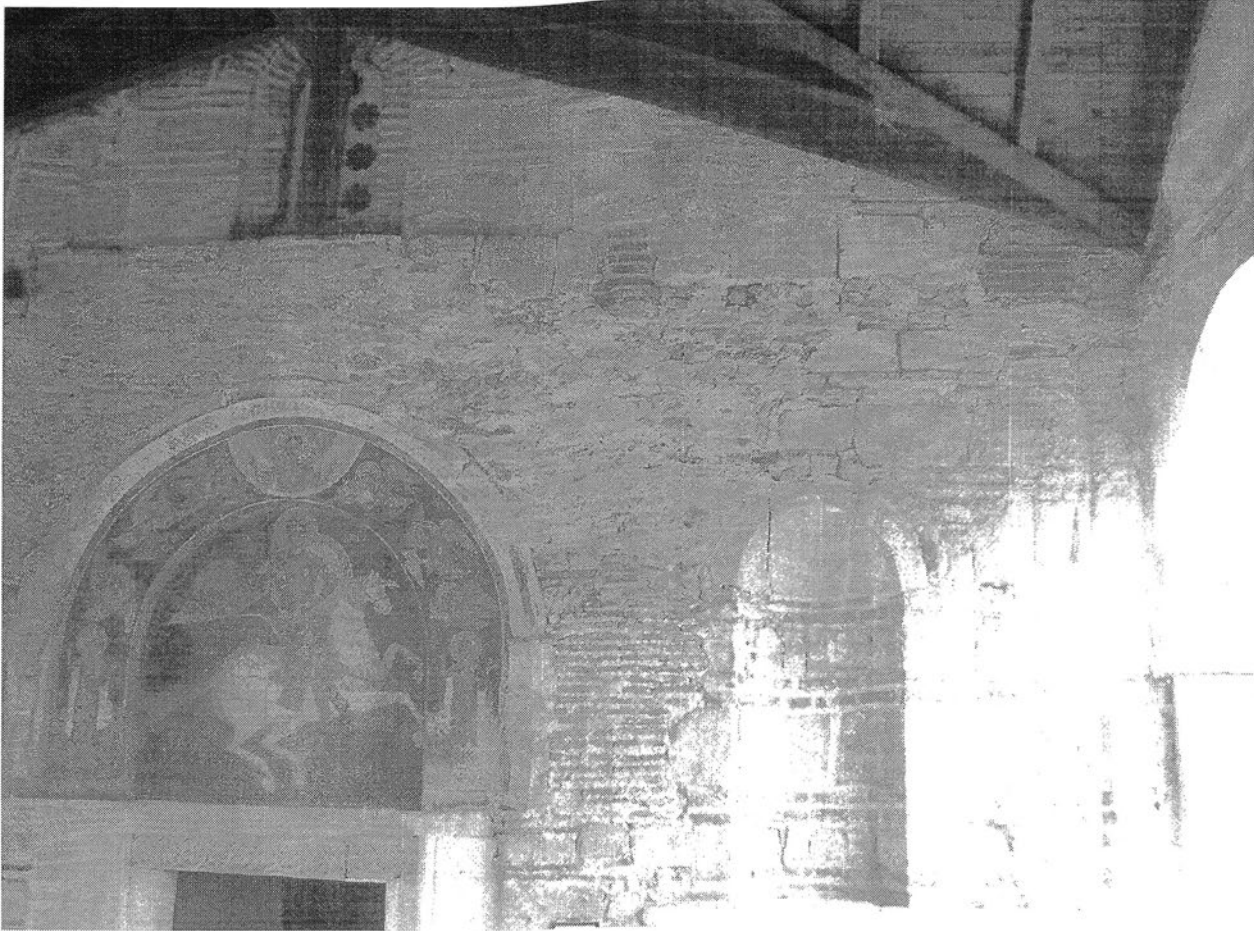
Сл. 132. Јужен и средишен дел од западната фасада под отворениот трем (состојба после интервенциите во 2007 г. кога се отстранети дрвените греди од тремот, а местата во ѕидот пополнети со нова ѕидарија)
