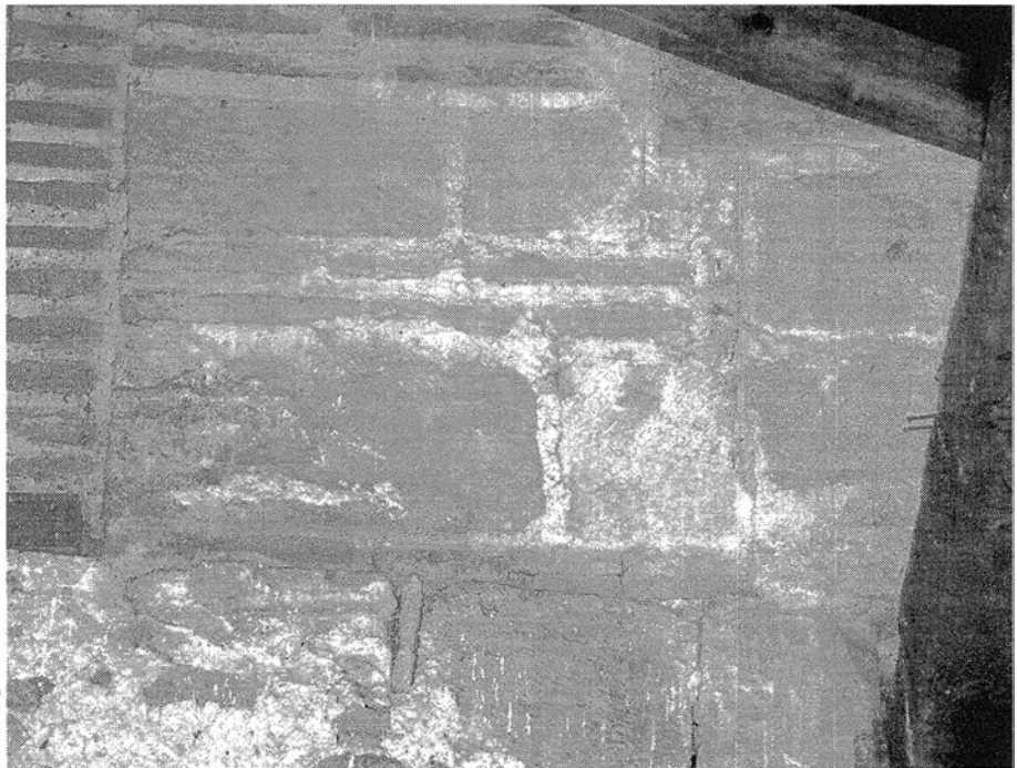
Сл. 139. Фрагмент од горната лачна ниша на западната фасада со видлива промена на сидаријата на лакот
