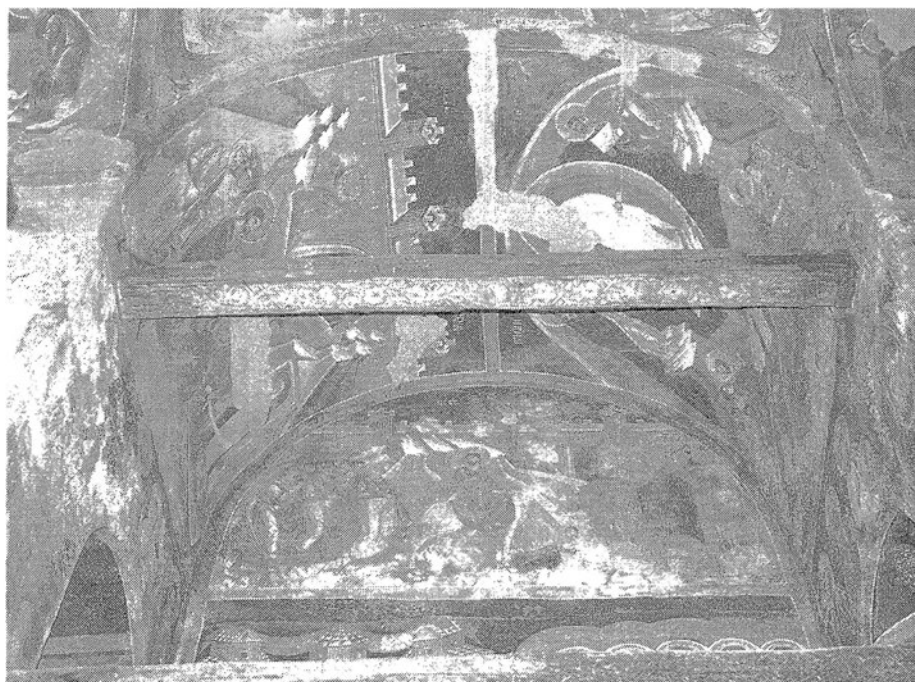
Сл. 179. Западен ѕид и горна конструкција од наос (во прв план се автентично осликаните дрвени затеги)
