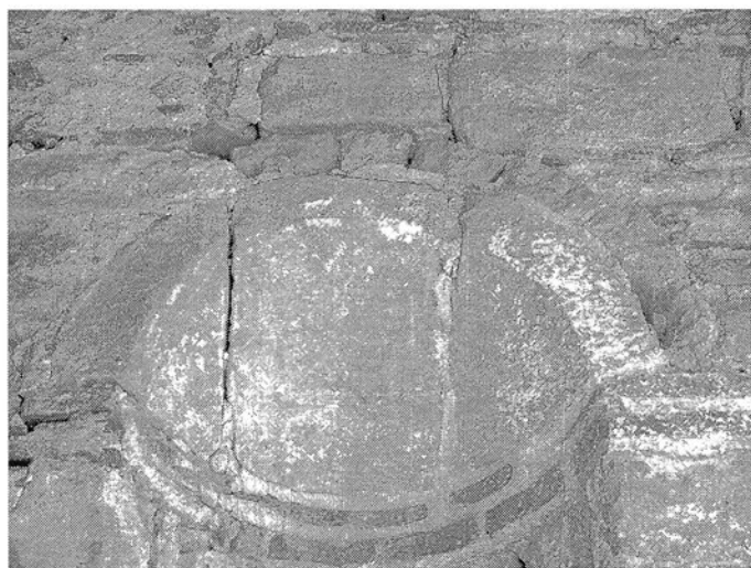
Сл. 146 а-в. Јужна ниша од западната фасада со видливи оштетувања и промени на сидаријата
