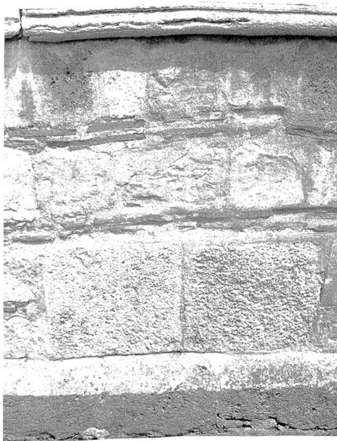
Сл. 54. Фрагмент од преправаната сидарија од првата зона на нартексот - јужна фасада
