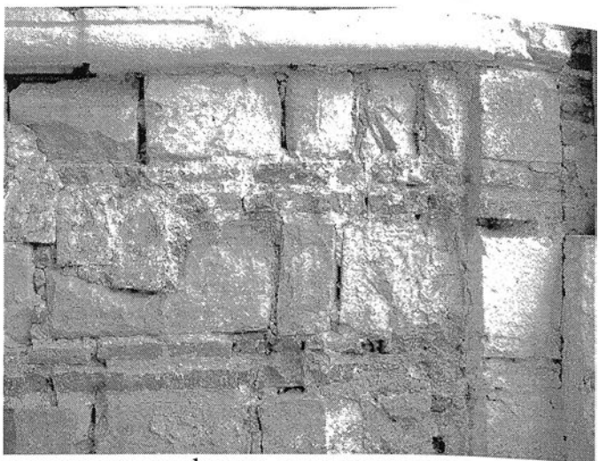
Сл. 151. Денешна состојба на профилираните пиластри на западната фасада со видливи исчукувања:
