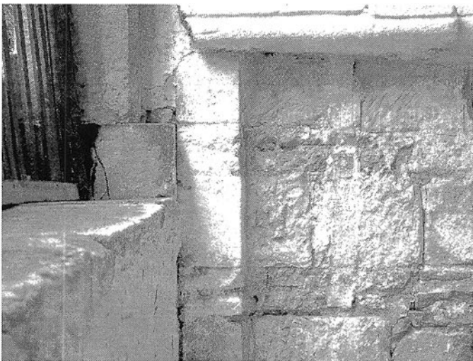
Сл. 151. Денешна состојба на профилираните пиластри на западната фасада со видливи исчукувања:
