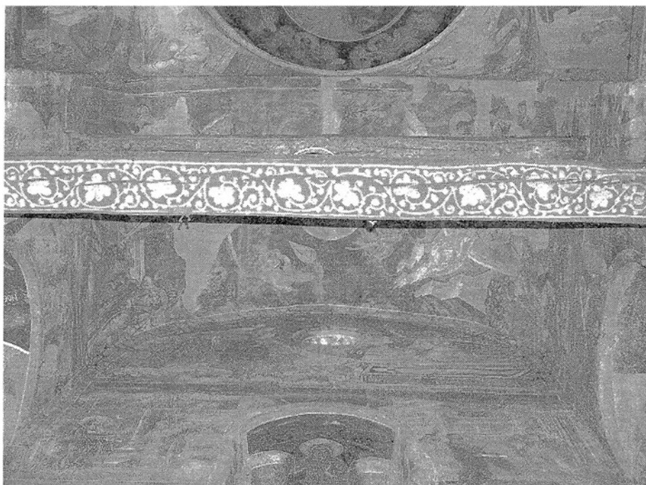
Сл. 166. Северен ѕид и горна конструкција од наос (во прв план се автентично осликаните дрвени затеги)
