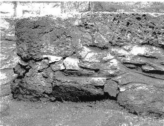
Сл. 114. Темелно цокле на југоисточниот дел од апсидата
