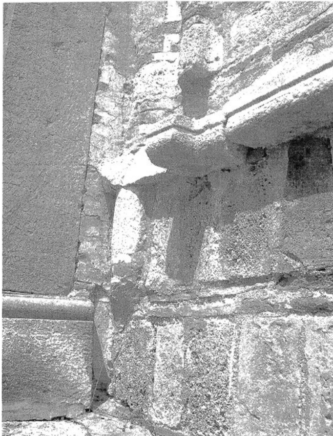
Сл. 53. Југозападниот профилиран пиластер со оштетувањата и преправките
