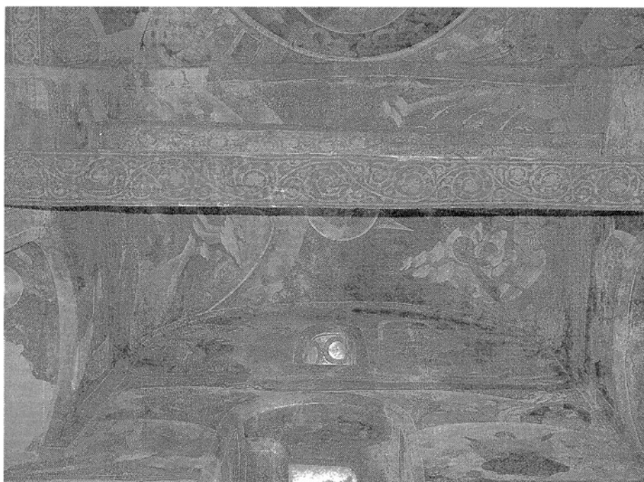
Сл. 173. Јужен ѕид и горна конструкција од наос (во прв план се автентично осликаните дрвени затеги)
