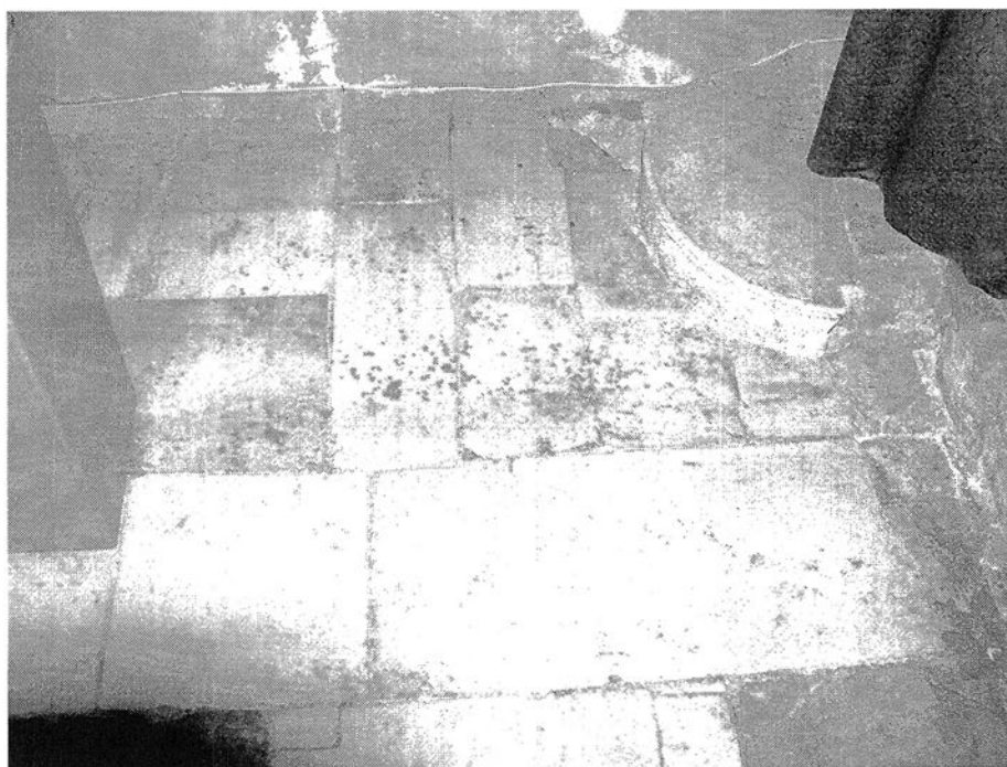
Сл. 239. Обработка на подот во северниот травеј од наосот на влезот во олтарскиот простор
