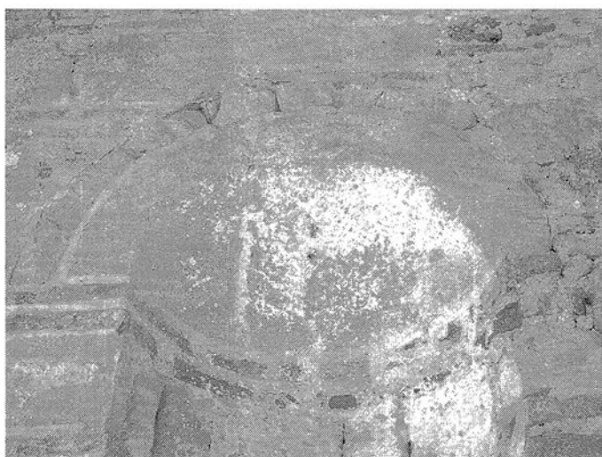
Сл. 145 а-в. Северна ниша од западната фасада со видливи оштетувања и промени на сидаријата
