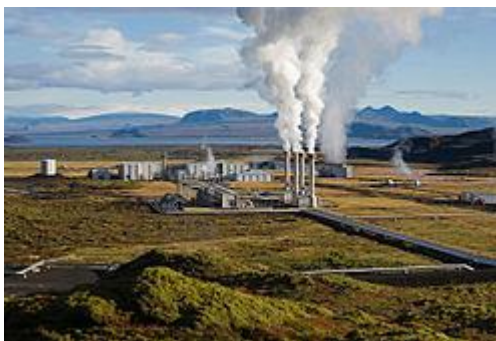
Слика 4.8 Геотермална електрана Несјавелир, Исланд
