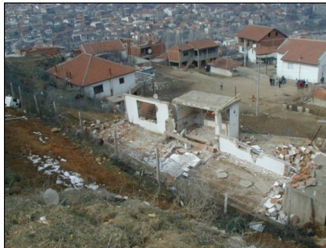
Слика 19. Последици од последната реактивација на свлечиштето Рамина 1999 год.
