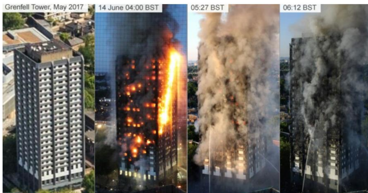
Слика 2.9. GRENFELL TOWER
