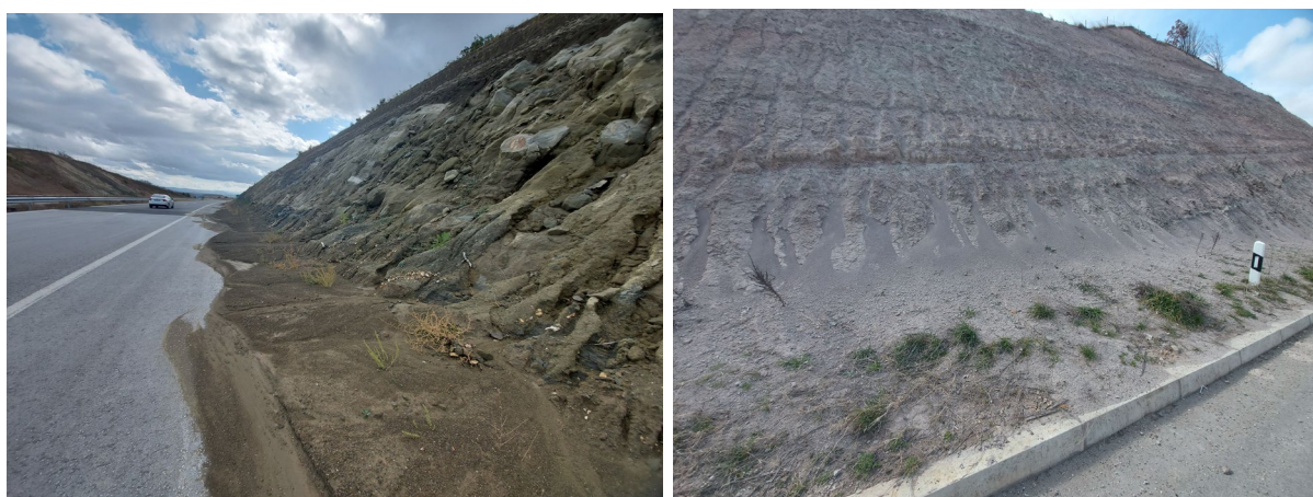
Слика 4. Изразена ерозија на косини од автопатот Миладиновци – Штип, ориентација североисток (Сусинов, октомври 2020 и март 2021 година)
