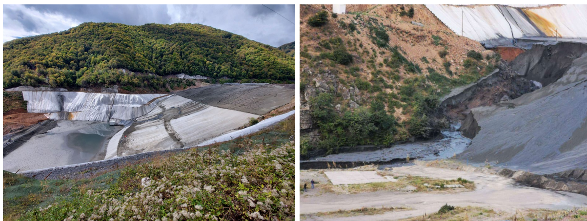
Слика 2. Лом на низводната косина на хидројаловишна брана бр. 4 во рудникот Саса Македонска Каменица (Сусинов, септември 2020 година)
