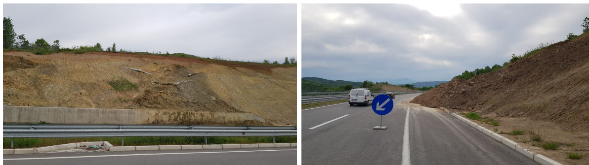
Слика 3. Свлекување на косина на автопат Миладиновци – Штип, ориентација северозапад (Сусинов, мај 2019 година)
