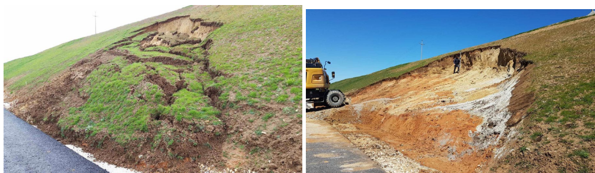
Слика 5. Свлекување на косини од експресен пат Штип – Радовиш (Сусинов, јуни 2020 година)
