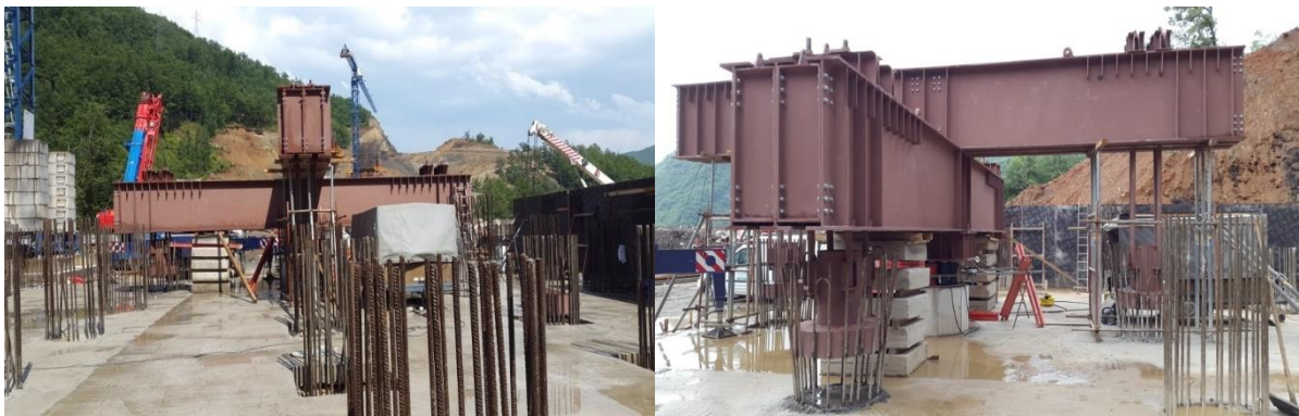
Слика 5.53. Приказ на реакционен систем, Е4
