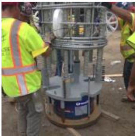
Слика 4.10. Хидраулична преса прикачена на дното од арматурен кош од бушен кол
