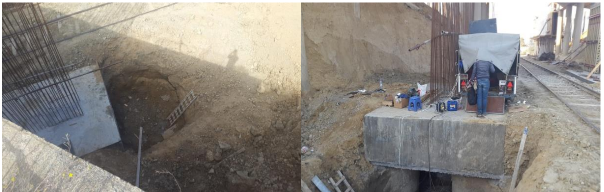
Слика 5.35. Приказ на подготовка на кол тестот, Е1
